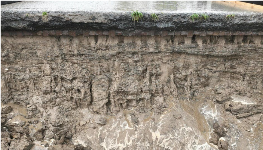
Figuur 77: Onder het asfalt was een klinkerbestrating aanwezig.
