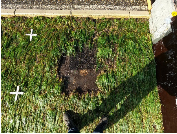
Figuur 53: Schadebeeld ter plaatse van de opsluitband einde proef GO50_3.2, teststrook 3.
