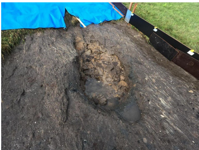
Figuur 55: Detail erosiegat boventalud na 0,5 uur GO100_3.2, teststrook 3.
