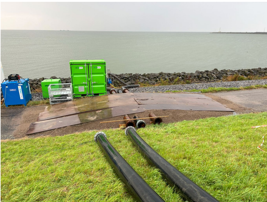
Figuur 3: Overrijconstructie inspectiepad
