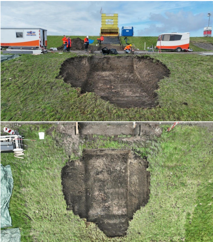
Figuur 73: Aangebrachte klif ten behoeve van de kliferosieproef, teststrook 1 (sessie 3).
