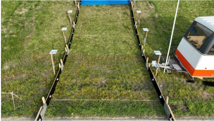
Figuur 36: Impressie boventalud teststrook 2.
