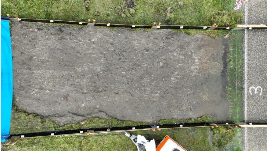
Figuur 51: Schadebeeld boventalud na één uur van proef GO50_3.2, teststrook 3.
