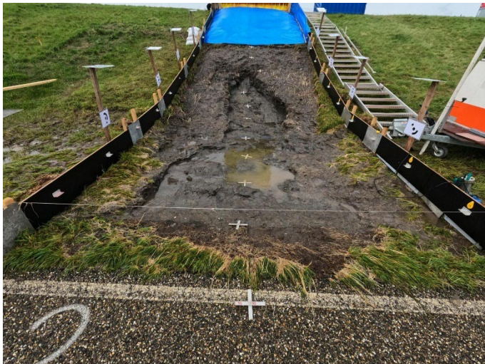
Figuur 41: Erosiekuil op het boventalud einde proef GO50_3.2, teststrook 2.
