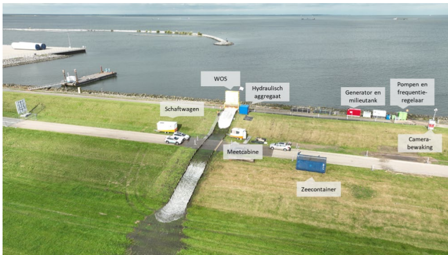
Figuur 1: Essentiële onderdelen proefopstelling golfoverslagproeven (WOS, hydraulisch aggregaat, meetcabine, schaftwagen, zeecontainer, generator, milieutank, camerabewaking, pompen en frequentieregelaar)
